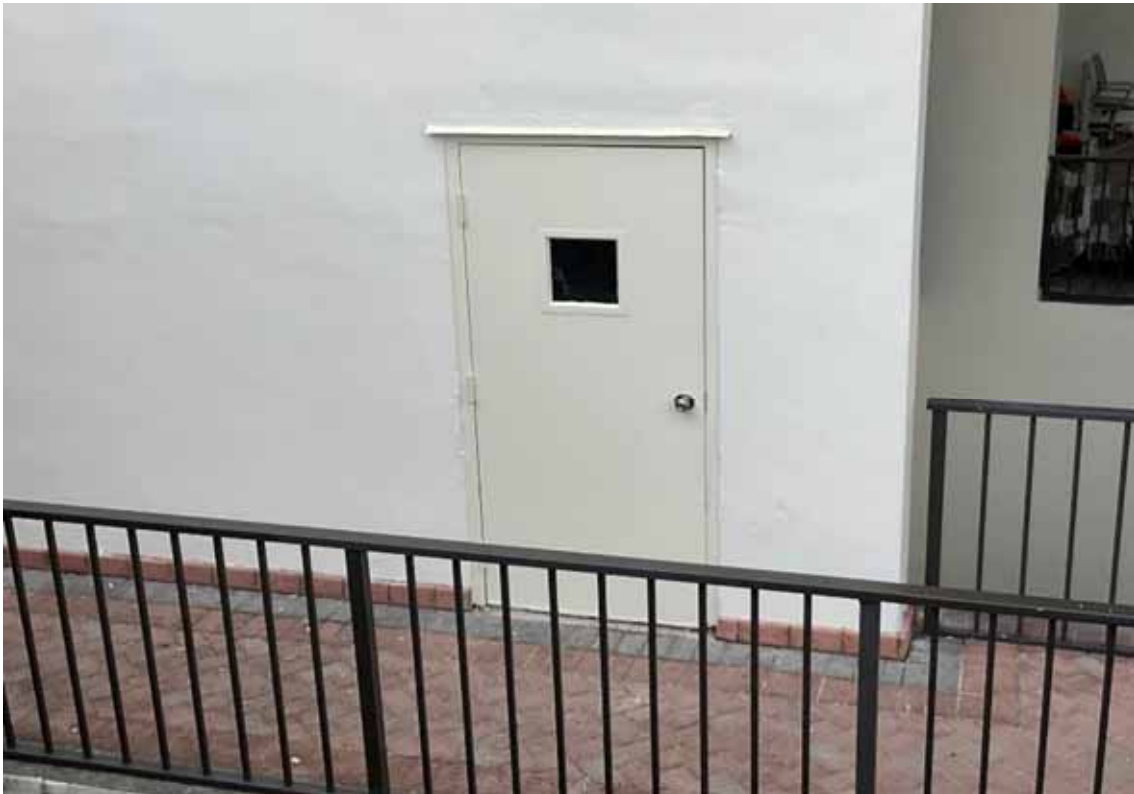
Door - Bldg D Stairwell
