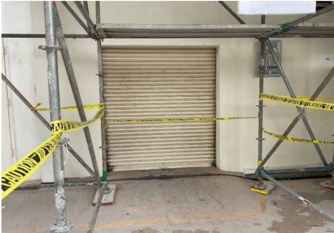
Door - Bldg D Trash Room
