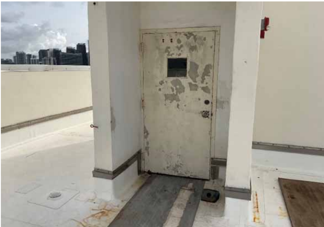
Door - Bldg D Roof Access
