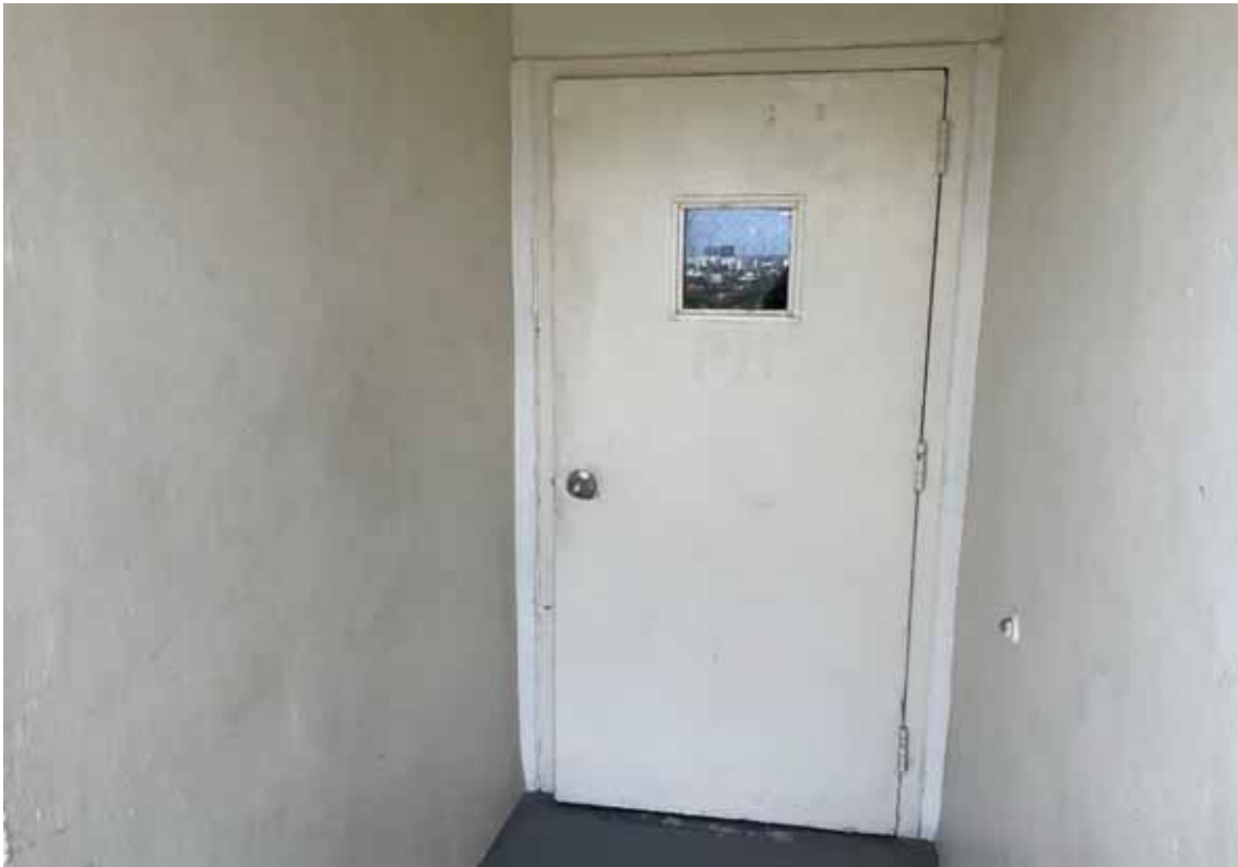
Door - Bldg D Hallway Access
