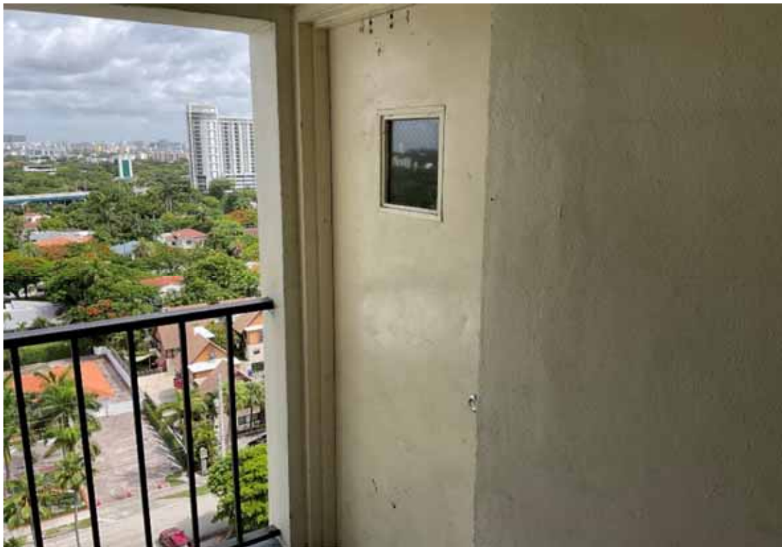
Door - Bldg C Stairwell
