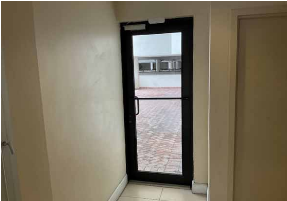
Door - Bldg C Lobby
