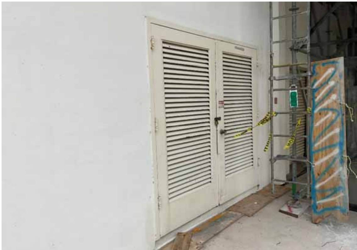
Doors - Bldg D FPL Vault
