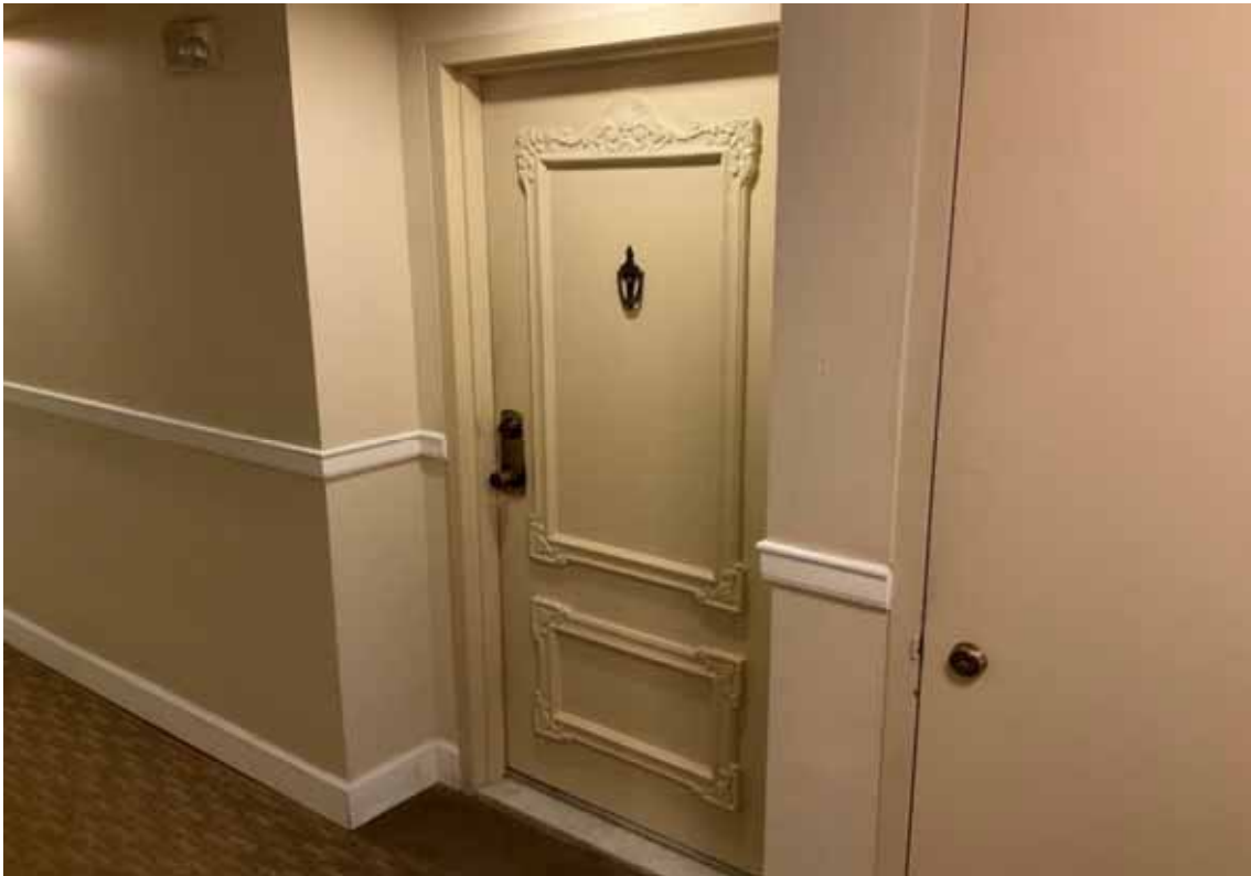
Bldg D Unit Door
