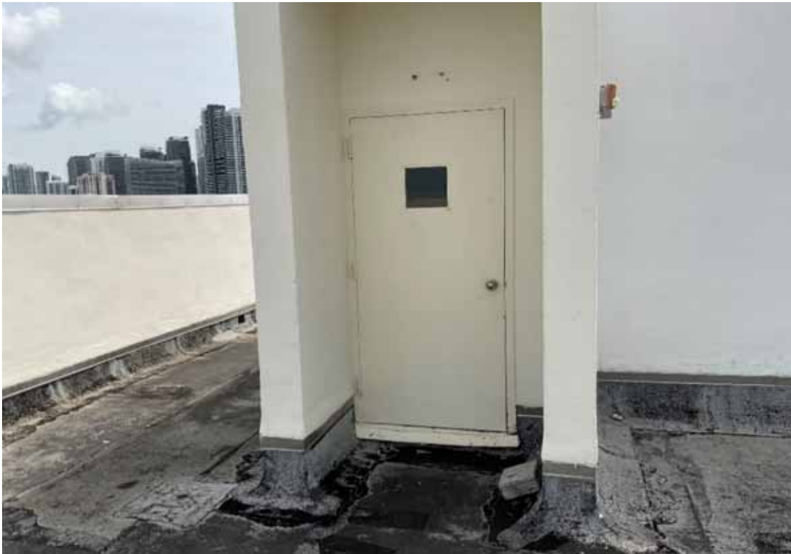
Door - Bldg C Roof Access
