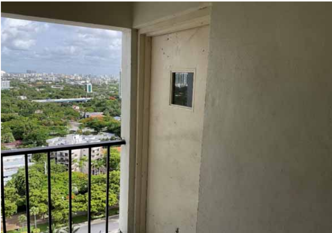
Door - Bldg D Stairwell
