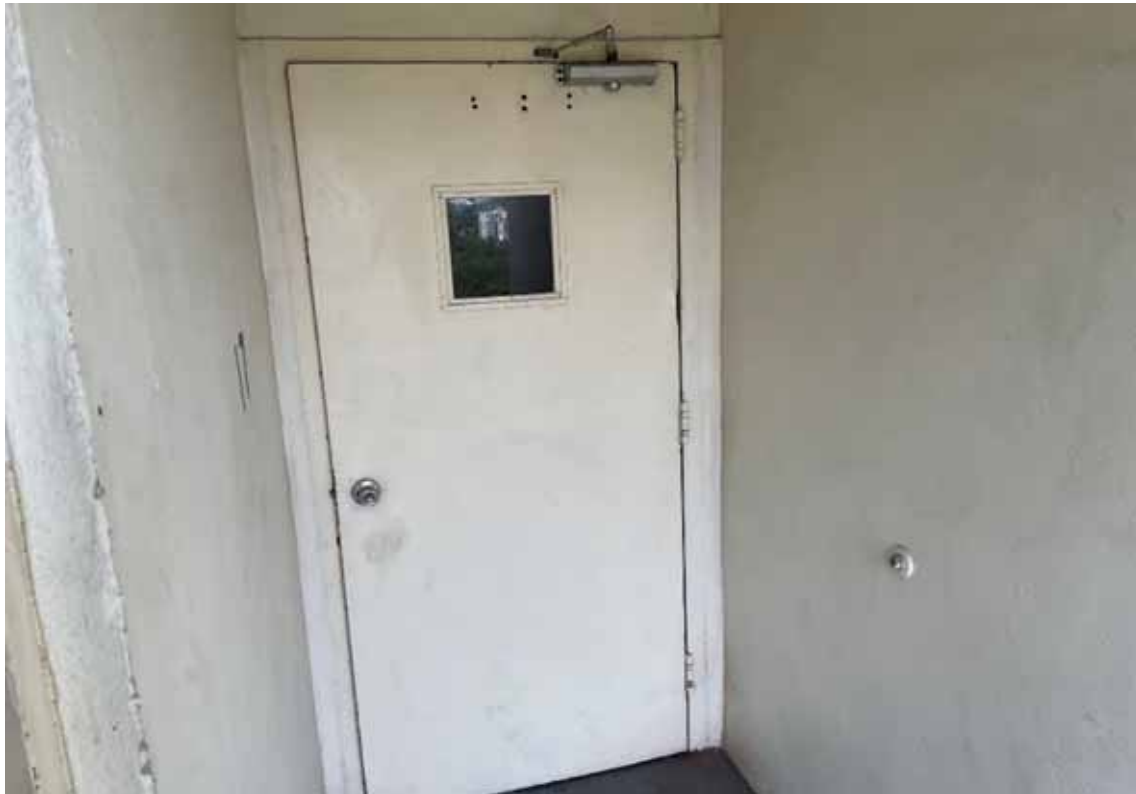
Door - Bldg C Hallway Access
