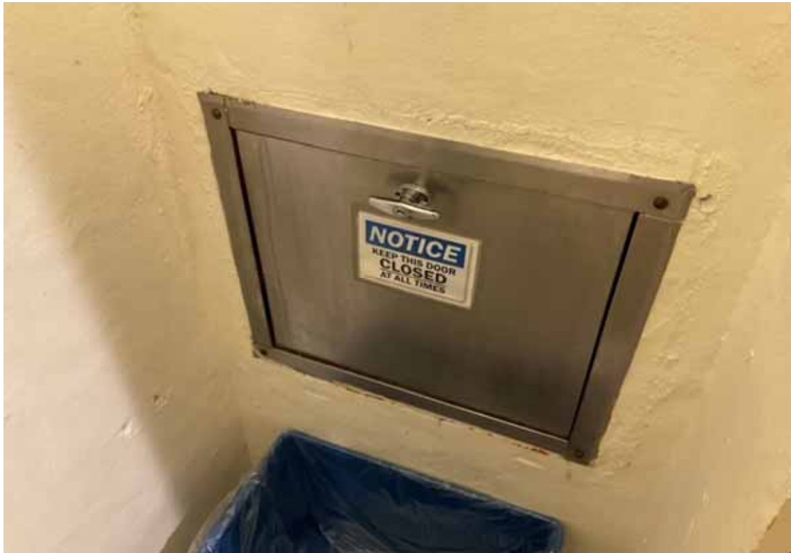
Bldg D Trash Chute Door
